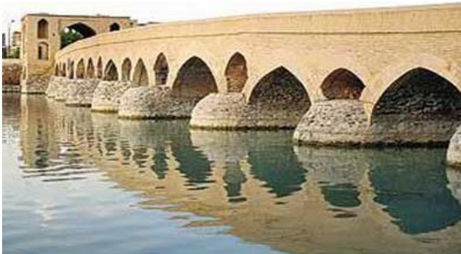
تصویر شماره هشت: پل جی
