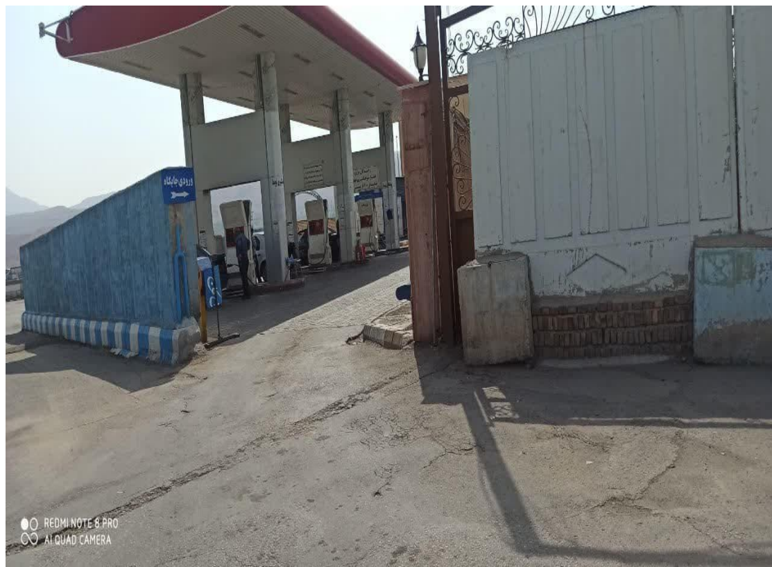
تصویر شماره ۲۲: مکانیابی نامناسب ایستگاه سوخت‌رسانی در اطراف پل آجی چای
